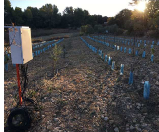
Murviel Reuse platform
