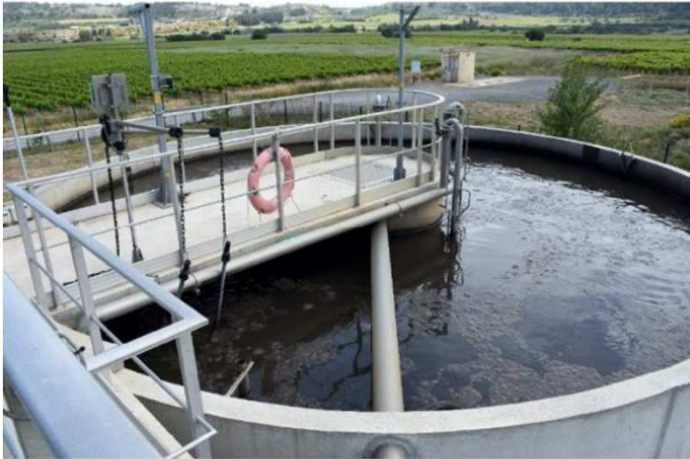
Requefort Les corbiere Reuse irrigation
