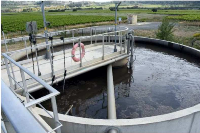
Requefort Les corbiere Reuse irrigation
