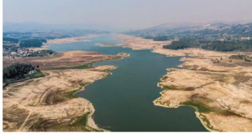
Seca A água que se perde em mais de 100 mil quilômetros de redes públicas para abastecimento humano é de 1,9 mil milhões de litros por ano. Falta de manutenção nos ramais é um problema
