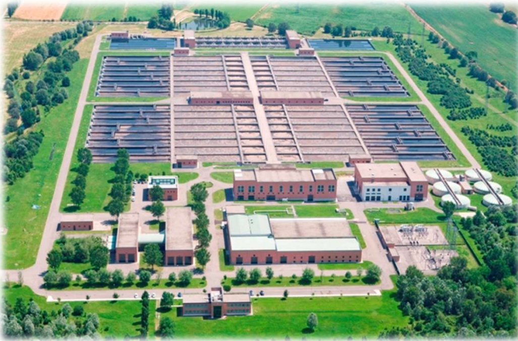
WWTP MILANO NOSEDO
