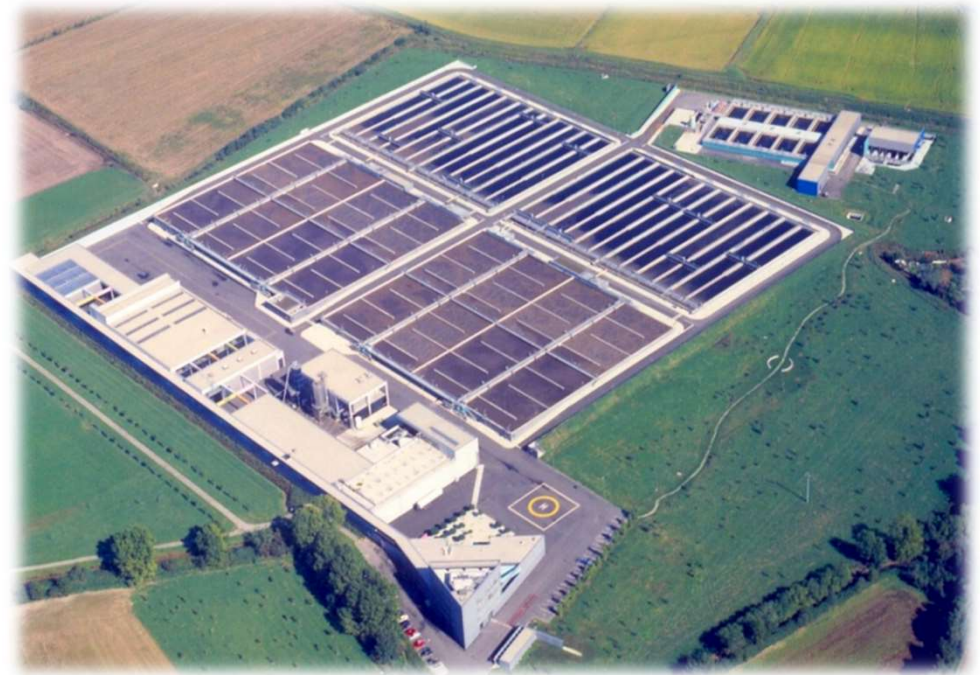
WWTP MILANO SAN ROCCO
